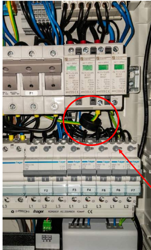
Spule zur Erfassung der Anzahl der Überspannungsereignisse
